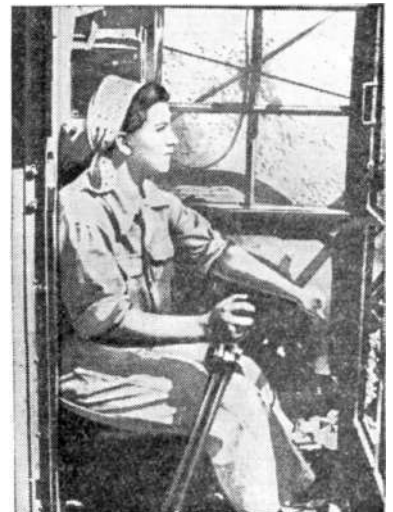
Экскаваторщица строительства канала Дунай—Черное море Елена Брыковьяну.
